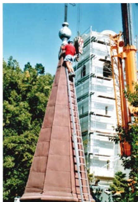
Fotografie: 5x oprava věže kostela
